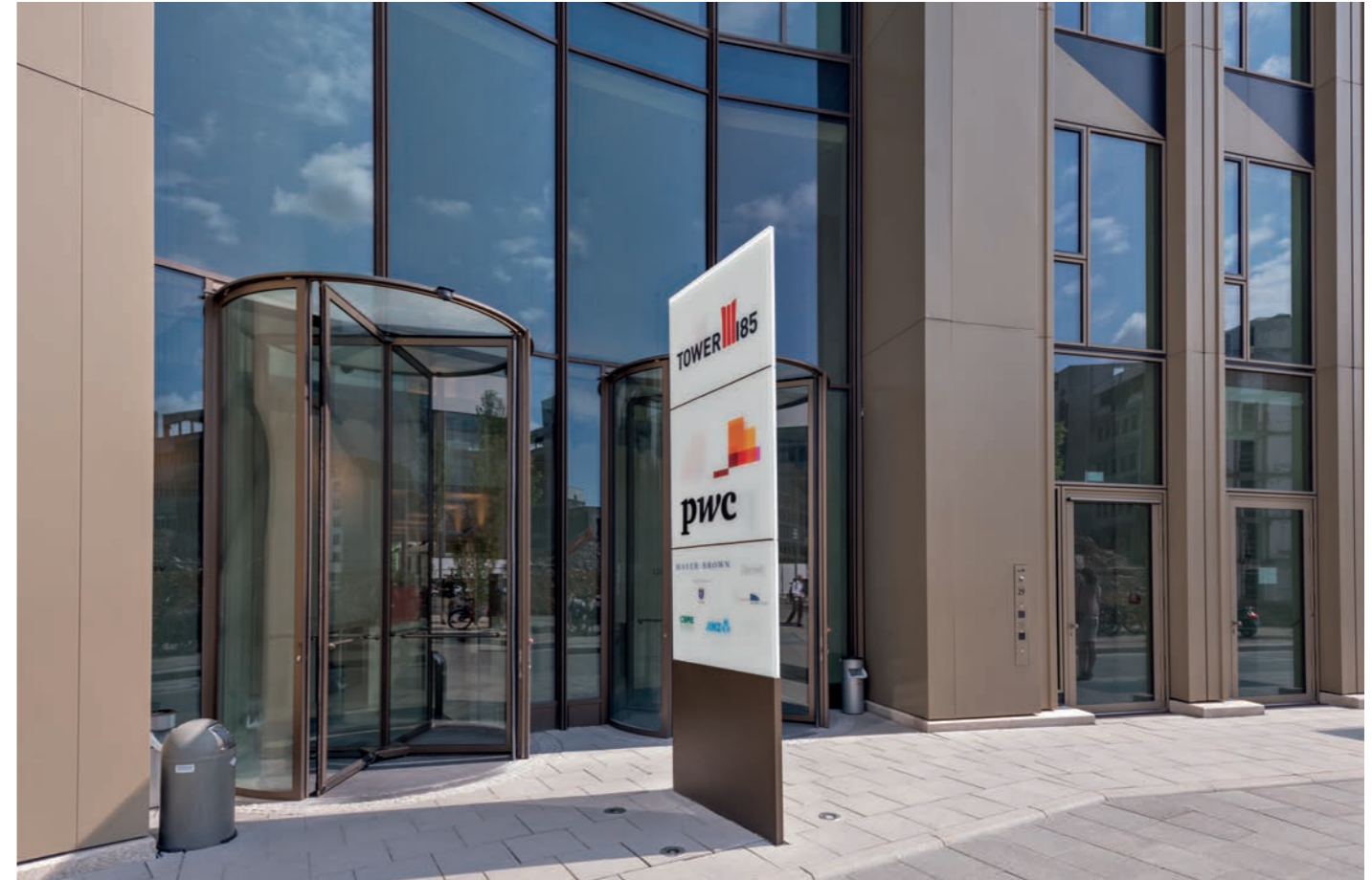
Haupteingang an der Gebäuderückseite
